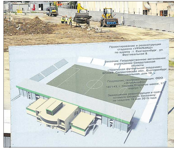
На «Уралмаше» демонтировано административное здание и часть трибун, срыт футбольный газон. Новая арена должна быть готова не позднее 15 мая
