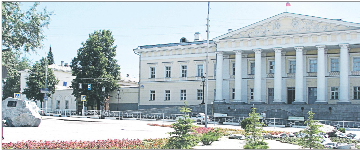
Ещё месяц назад на площади вовсю работала строительная техника. Уже сегодня здесь аккуратно уложена плитка и высажены растения
