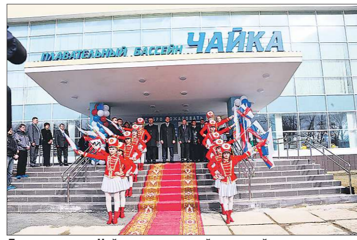
День открытия «Чайки» после долгой и трудной реконструкции стал для Кировграда настоящим праздником
