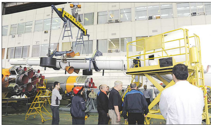
Монтаж системы аварийного спасения
