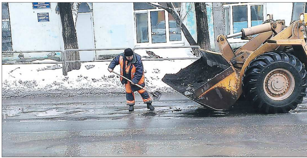
Дороги портят не шины с шипами, а вот такой «мокрый» ремонт
