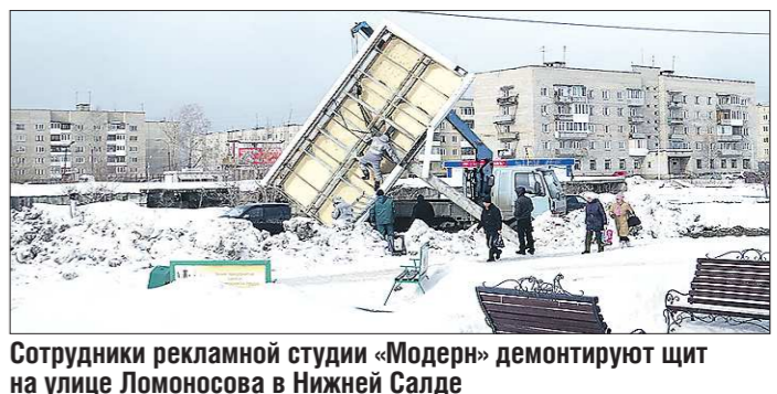
Сотрудники рекламной студии «Модерн» демонтируют щит на улице Ломоносова в Нижней Салде
