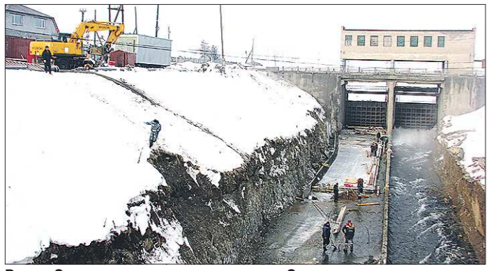
Русло Салды поделено на две части. Слева подрядчики укладывают бетон, а справа — набирающая силу вода
