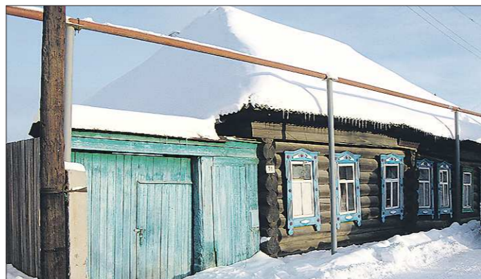
Небольшой ремонт — и ямская изба-шестьстенка с полуторакковой историей вновь сможет принимать заезжих постояльцев
