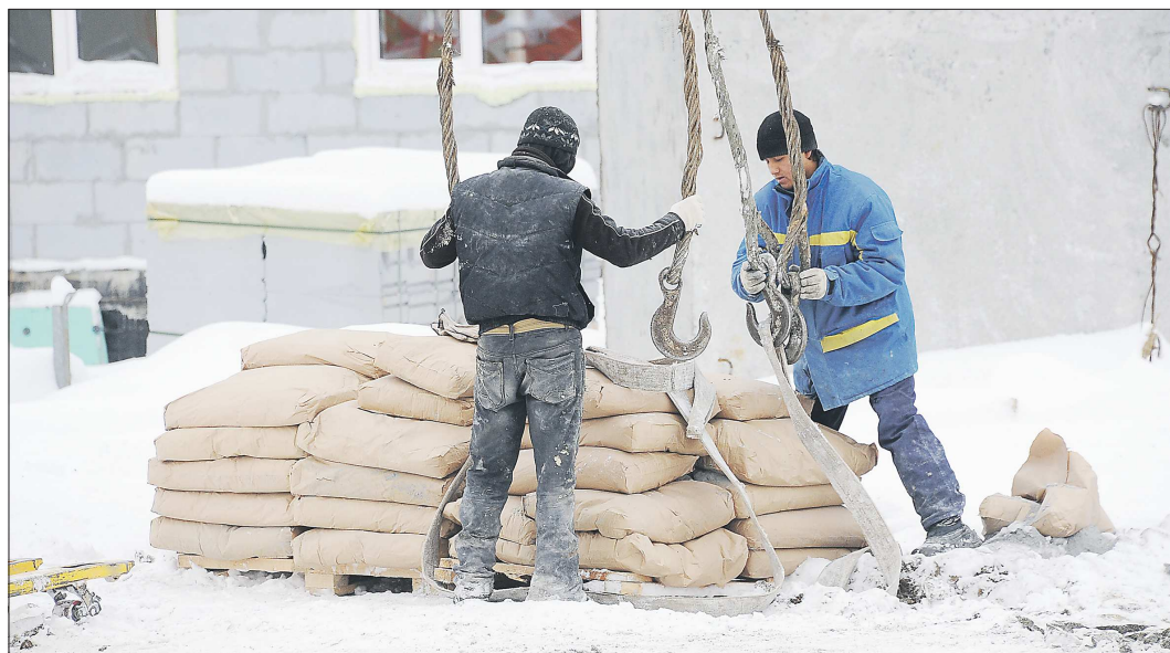
На стройках области сотни вакансий каменщиков, бетонщиков, стропальщиков
