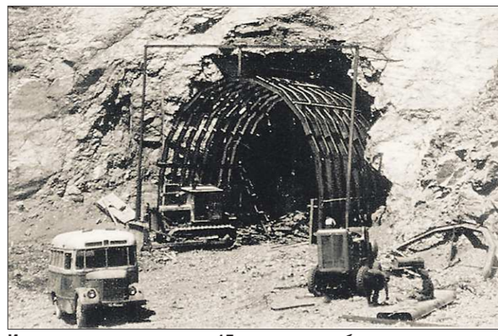
Из недр строители вынули 15 миллионов кубометров земли. Подземный завод вмещал три ядерных реактора, ТЭЦ, объекты жизнеобеспечения. При желании там могли разместиться до 500 тысяч человек
