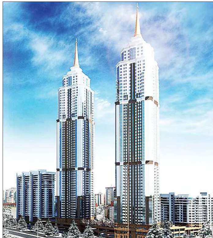
Ожидается, что и высота потолков в башнях «Первого Николаевского» будет как в «сталинках». В первом, нижнем, поясе высота будет 3,3 метра, во втором, среднем, поясе — 3,6 метра, а в самом верхнем — 4 метра
