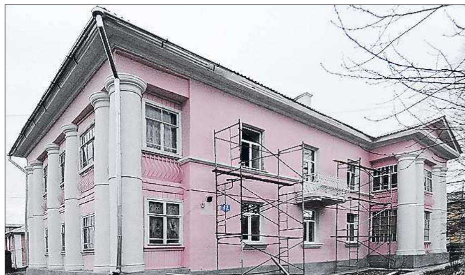
В текущем году в области проводится капитальный ремонт 181 многоквартирного дома в 12 муниципальных образованиях. Это здание в Серове тоже обычный многоквартирник
