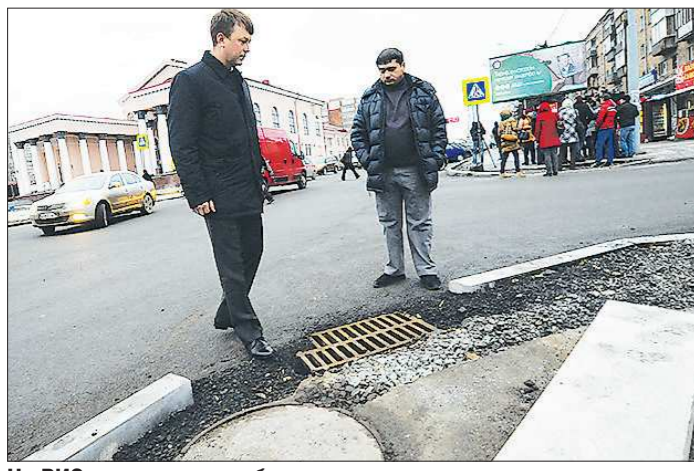
На Визе ремонтные работы до сих пор не завершены
