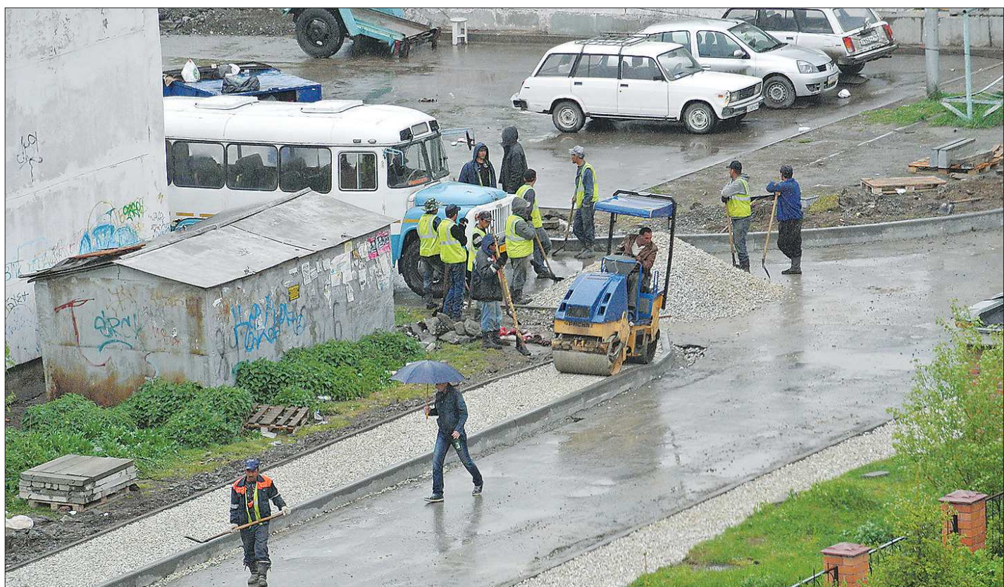
Дорожные работы в дождь — для Екатеринбурга, к сожалению, не редкость
