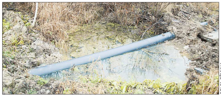
Семиклометровый участок трубопровода проходит по болоту
