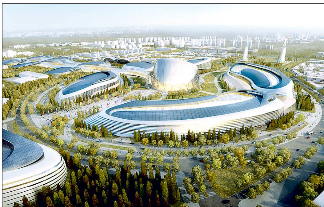
Так будет выглядеть выставочный комплекс ЭКСПО-2017 в Астане. Пока на этом месте — пустырь
