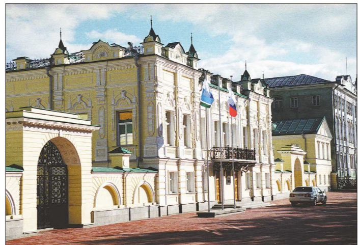
Архитектор Заславский, реконструировавший усадьбу, использовал в отделке здания кашлинское литьё, уральский белый мрамор и змевики
