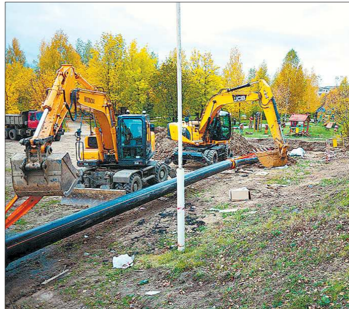
Строители не тронули детскую площадку, прокопав под ней земляной тоннель для труб
