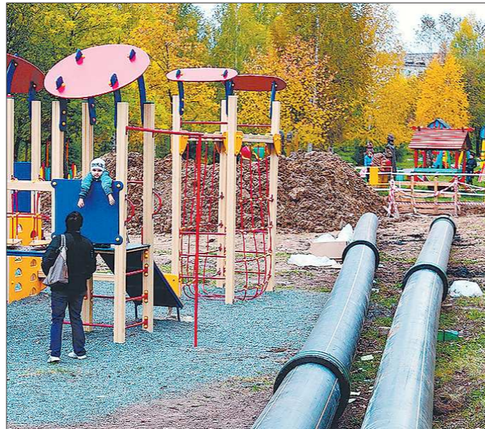
Строители не тронули детскую площадку, прокопав под ней земляной тоннель для труб
