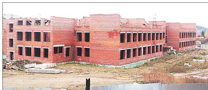
Такой школьная стройплощадка была ещё полгода назад
