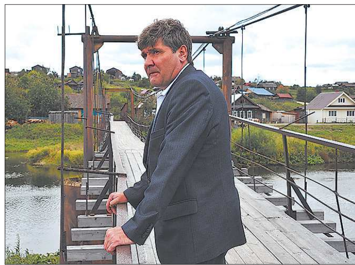
Подвесной мост через Чусовую при ходьбе качается и поскрипывает. «Но он абсолютно надёжен», — уверяет глава городского округа Староуткинск Сергей Кузовков
