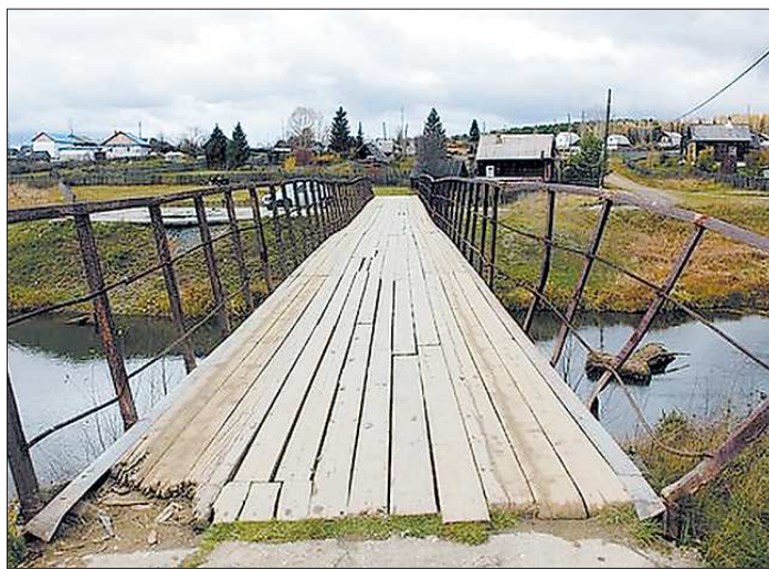
Перила на аварийном мосте в Именновском отогнули специально, чтобы большие машины не цепляли бортами
