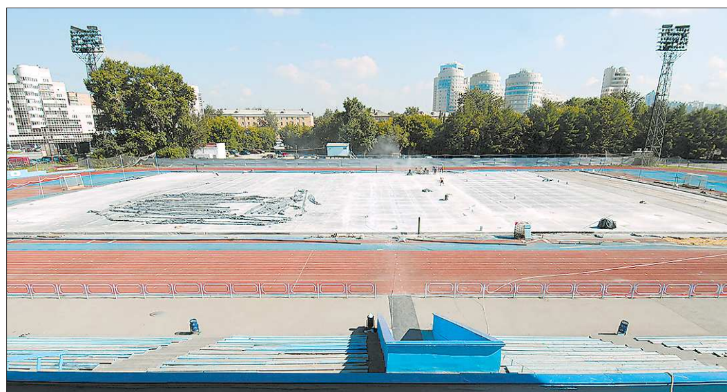
На поле стадиона «Динамо» работа идёт в три смены, практически круглосуточно
