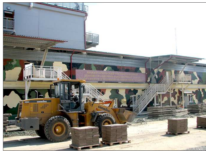
В настоящее время УВЗ активно ремонтирует здания и сооружения полигона
