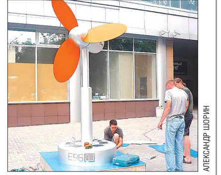
Те же самые рабочие, которые устанавливали этот памятник, к годовщине обновляют его фундамент
