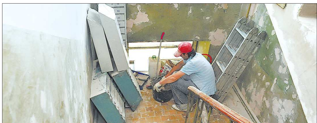
В подвале дома на Академической, 236, кроме основных работ, по просьбам жильцов меняют все окна и устанавливают новые почтовые ящики
