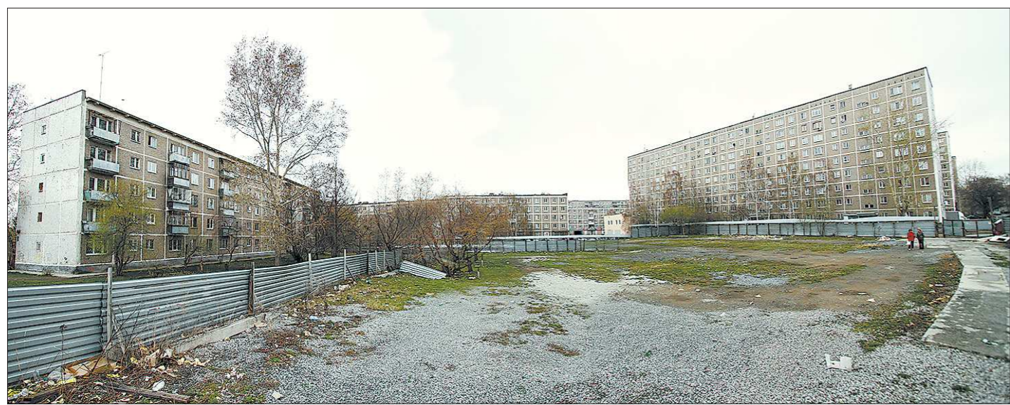
Узкие полоски земли под окнами — вот и вся дворовая территория трёх домов по улице Крауля
