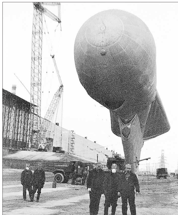
Аэростат, освещавший жерло чернобыльского саркофага, вмещал более двух тысяч кубометров гелия. Когда часть газа улетучивалась, «сигару» подтягивали к земле на дозaprавку
