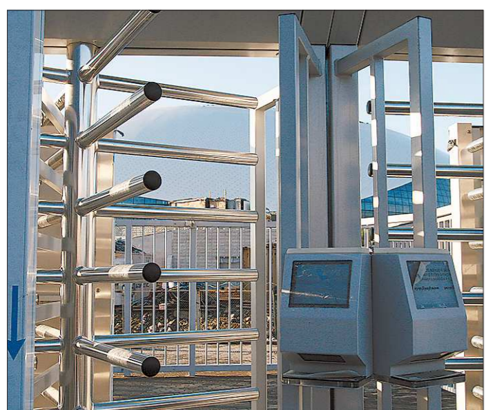
Последнее испытание для болельщиков на пути к олимпийским аренам – «вертушки» во весь человеческий рост. Установленные на них аппараты будут сканировать билет и пропускать зрителя к объектам
