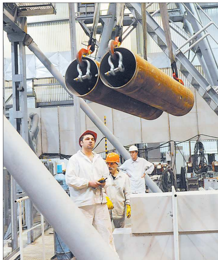
Строительство энергоблока БН-800 ведётся в три смены
