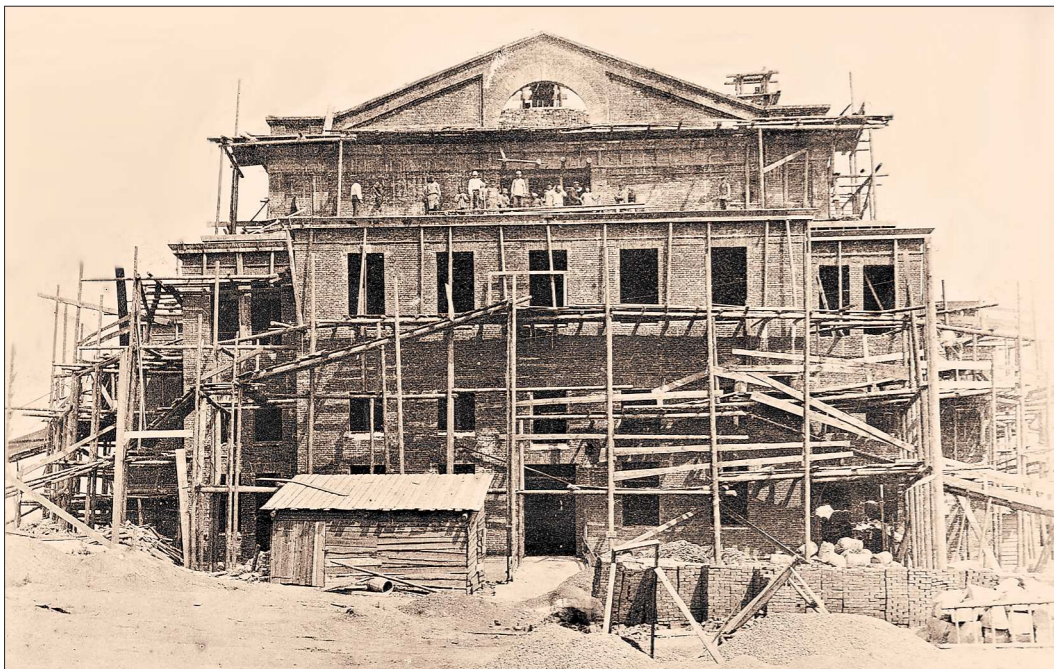
Один из этапов строительства Екатеринбургского городского театра под руководством архитектора Константина Бабыкина
