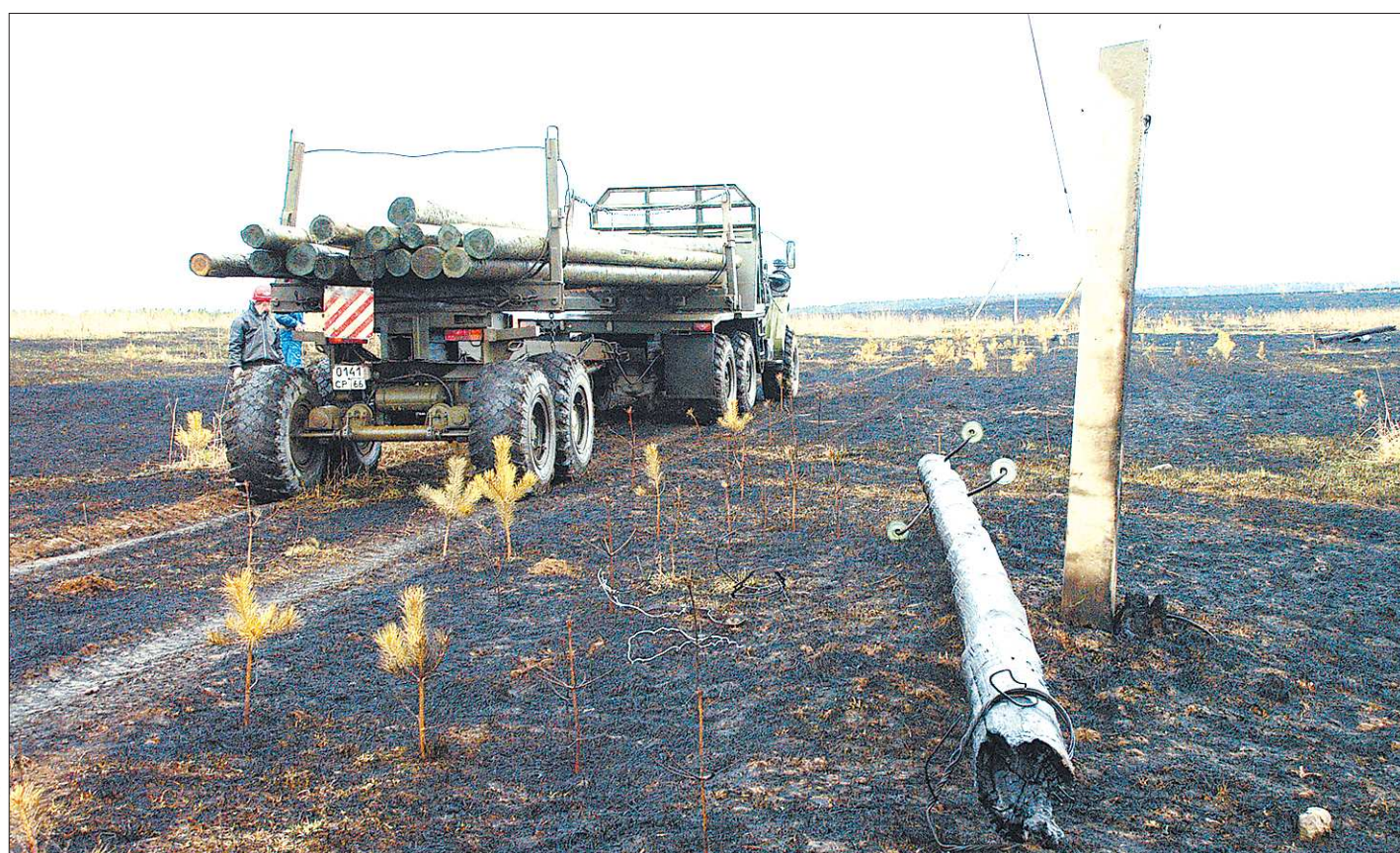
Пожар даже в чистом поле может нанести серьёзный ущерб хозяйству: на выжженном огнём участке приходится восстанавливать опорные столбы для линии электропередачи
