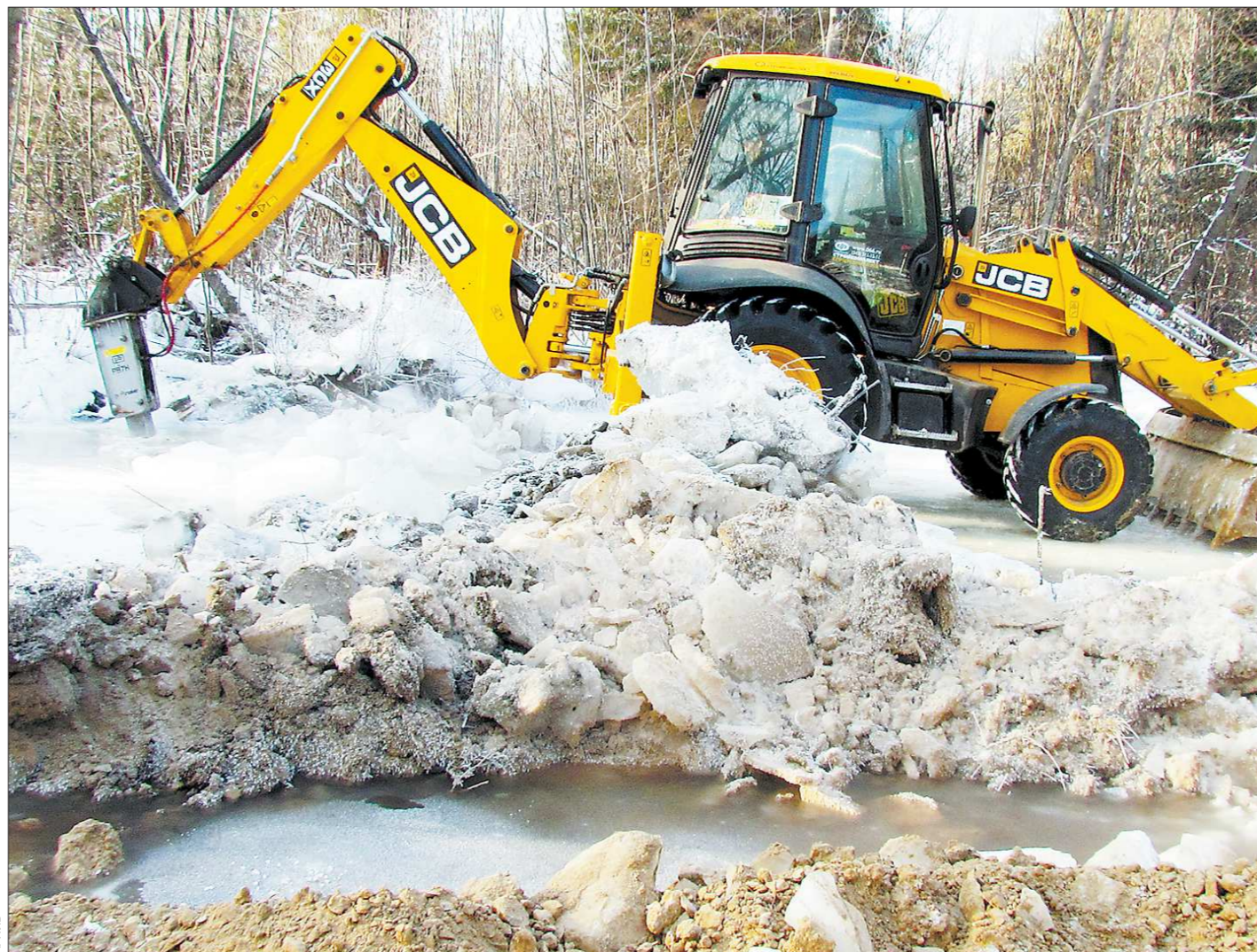
Из-за холодов река Шайтанка промерзла до дна. Чтобы обеспечить доступ воды в водохранилище, коммунальщики вынуждены с помощью техники вскрывать замёрзшее русло
