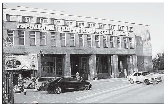
В последний раз крышу Дворца творчества юных ремонтировали 12 лет назад. Здание выполнено по индивидуальному проекту, здесь предусмотрены условия для занятий детей-инвалидов. Крыша учреждения имеет сложную конструкцию, большая её часть прозрачна, есть также участки мягкой кровли
