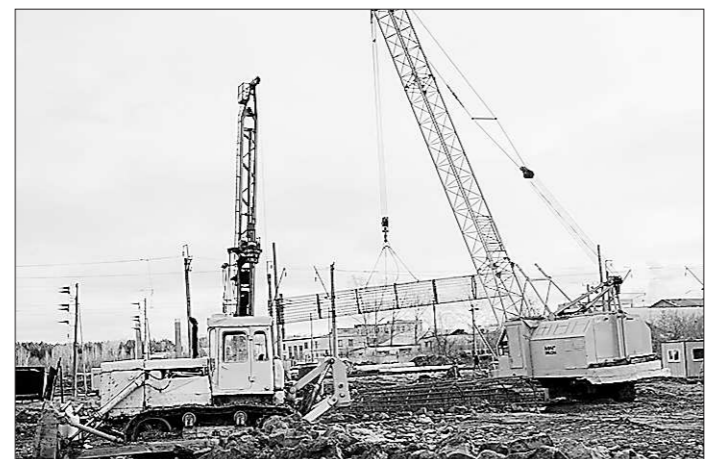
Сейчас в районе Богдановичского переезда ведётся перекладка инженерных сетей
