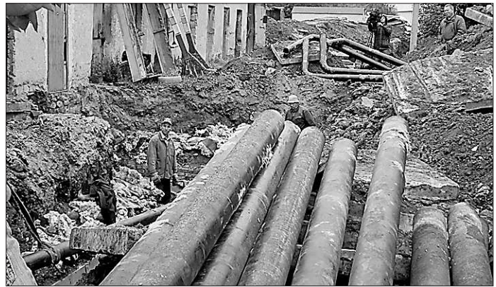
Коммунальный пейзаж на Елизаветинском шоссе: выкопаны старые трубы, уложим новые
