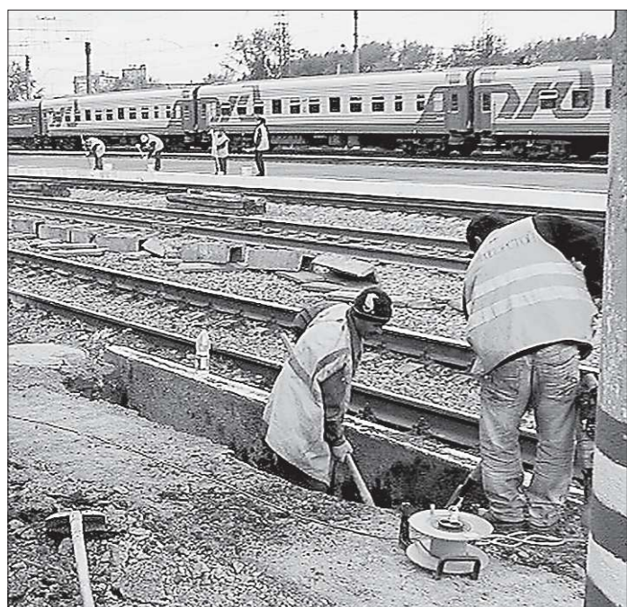
На перроне идёт реконструкция подпорной стены
