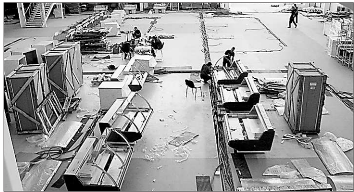
В помещениях выставочного центра сейчас монтируют оборудование
