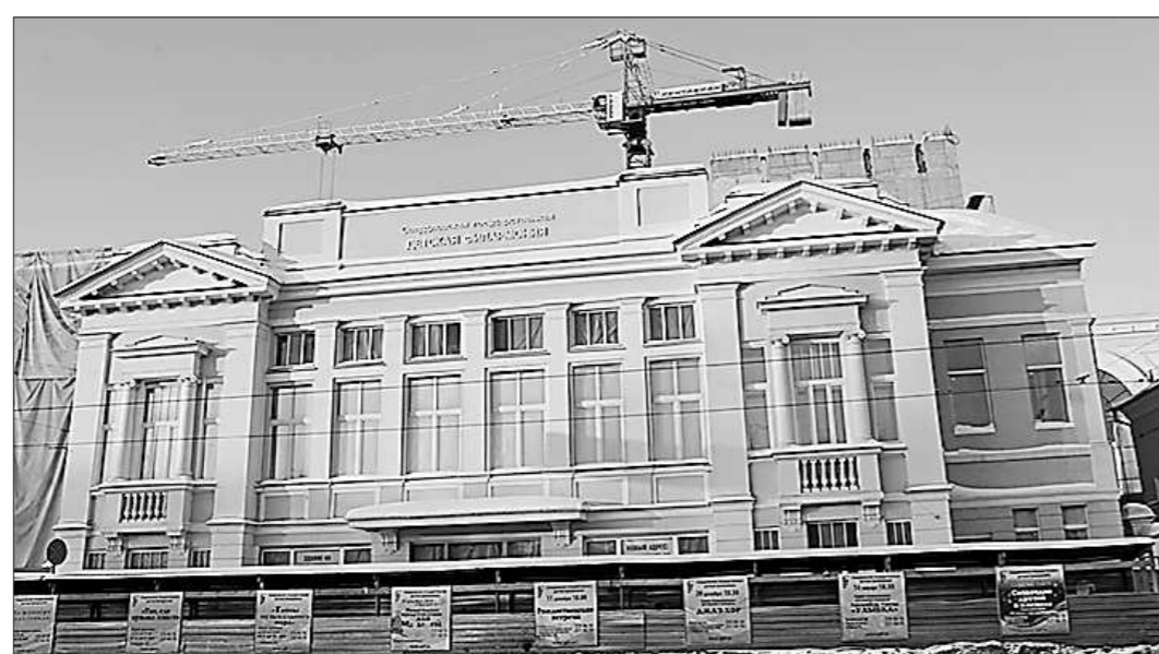
Так выглядит стройка сегодня. Фото Алексея КУНИЛОВА
