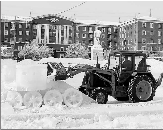
Демонтаж ледового городка в Ревде. Фото автора
