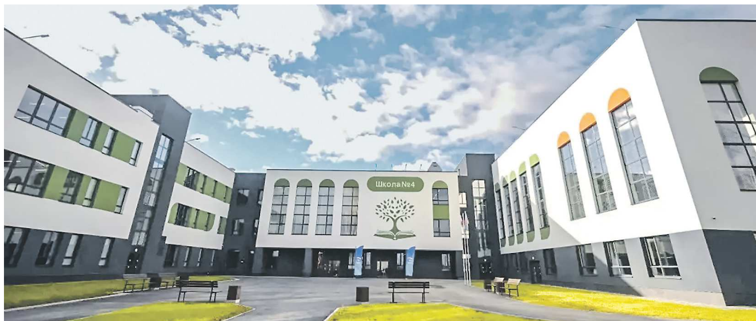
Трехэтажный корпус новой школы в Сосьве построен всего за два года
