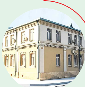
Здание администрации Пышминского МО (пгт Пышма, ул. 1-го Мая, 2)
