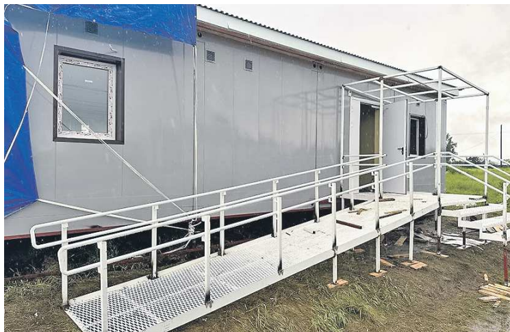
Модульные здания будущих ФАПов практически готовы
