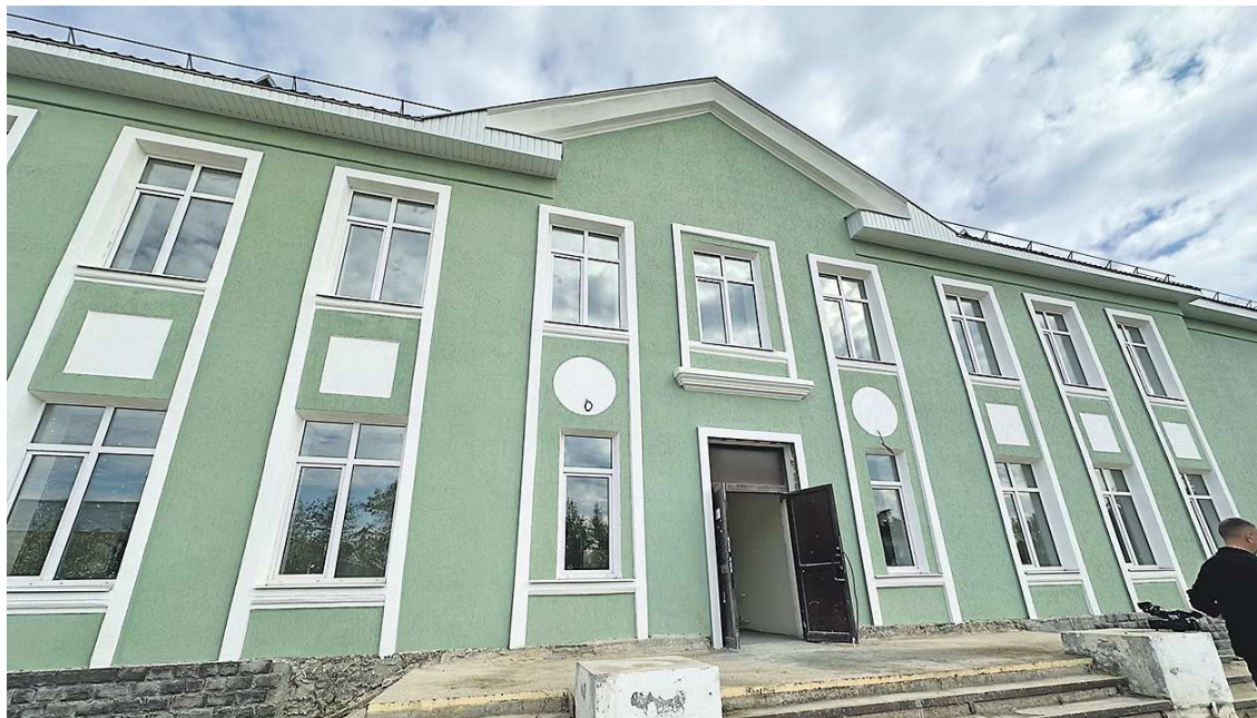
В отремонтированном здании школы №4 будут учиться профильные классы естественно-научной направленности. Объект планируется сдать до 1 сентября
