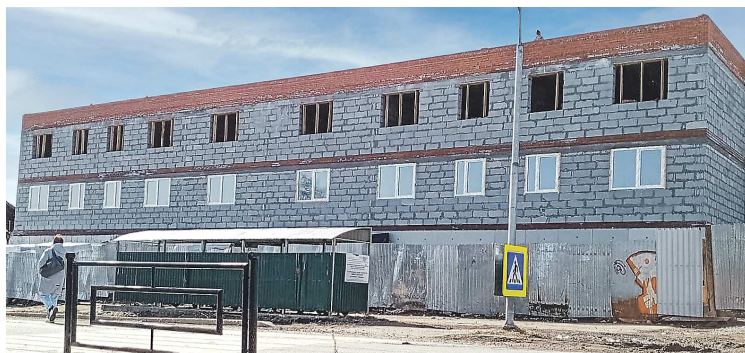
Коробка дома в поселке Аять уже готова, внешние работы на объекте продолжаются
