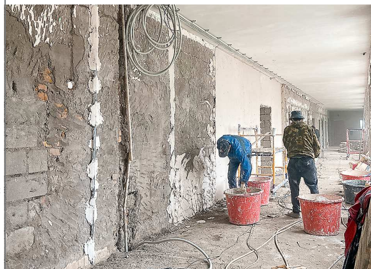
Ремонтные работы в школах начались весной этого года
