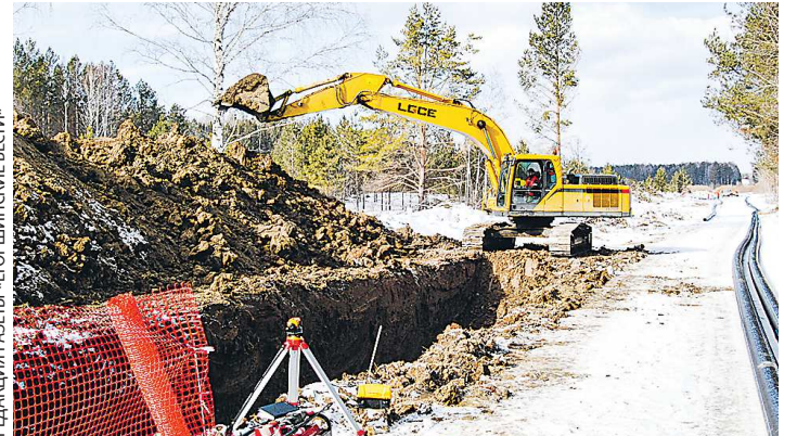
Подрядчики выкапывают траншею для водовода, глубина залегания которого составит около трех метров
