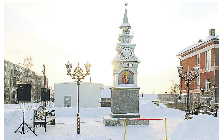
Башню выполнили из стали с антикоррозийным покрытием с применением отделки «Дикий камень»
