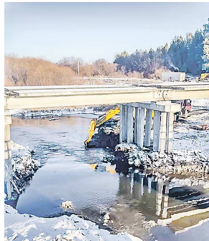
Один из крупнейших дорожных проектов Ирбитского района — реконструкция моста в деревне Симанова
