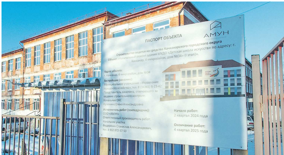
В этом году в Качканаре начался капитальный ремонт здания Детской школы искусств
