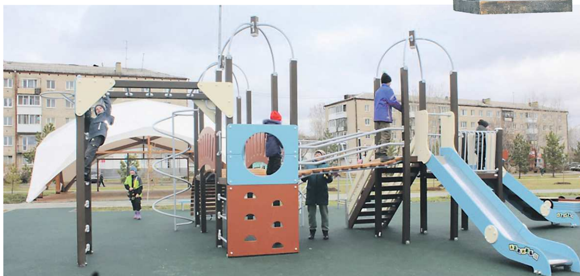
Благоустройство парка планируется полностью завершить в 2026 году
